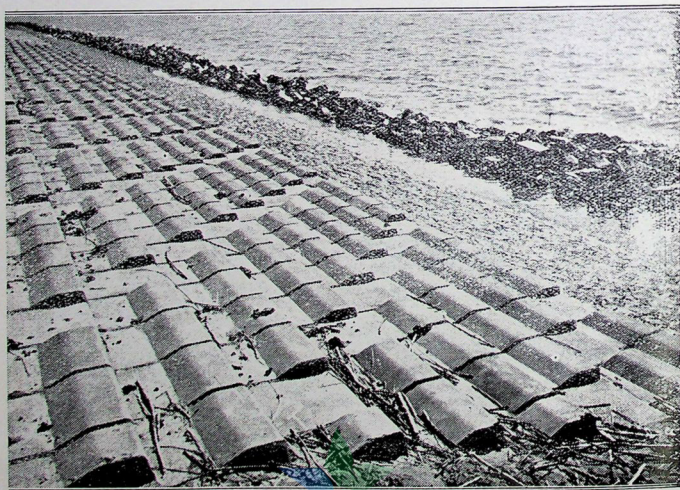
NEDERLANDSCH FABRIKAAT. — Om de Nederlandsche industrie te begunstigen heeft men den dijk te Urk, bij wijze van proef, met deze, in Nederland vervaardigde steenen bekleed, in plaats van basaltblokken. Als golfbreker schijnen de steenen uitmuntend te voldoen.
